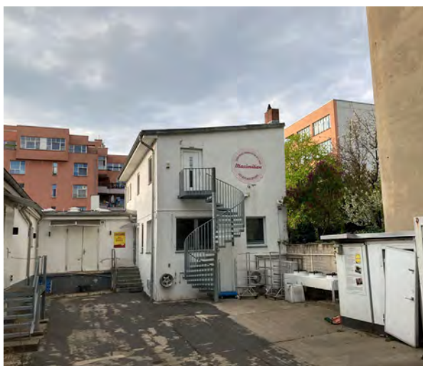
Ansicht Hof mit Remise heute
