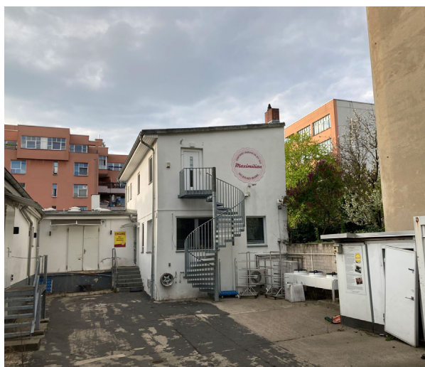
Ansicht Hof mit Remise heute
