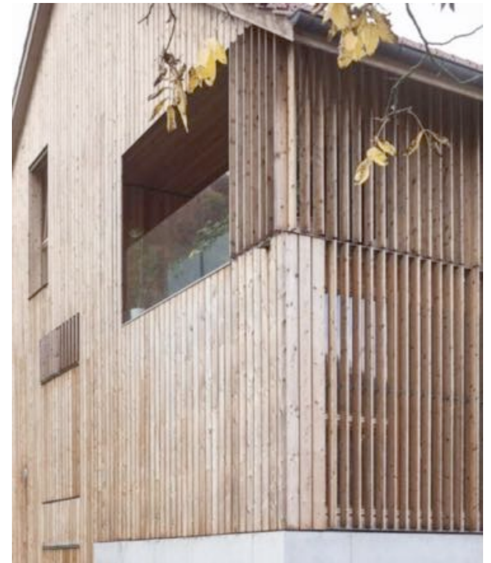
Beispiel Loggia Fassadenecke Süd
