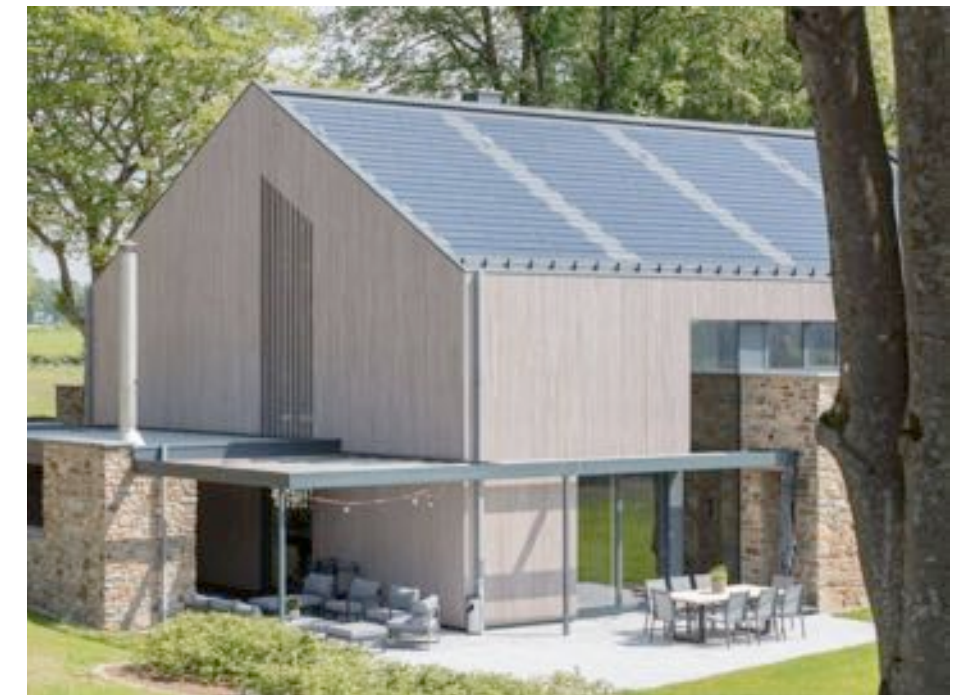
Beispiel Indach-Photovoltaik
