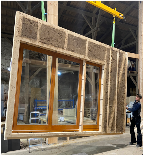
Aussenwand: Stroh-Lehm Holzelement
