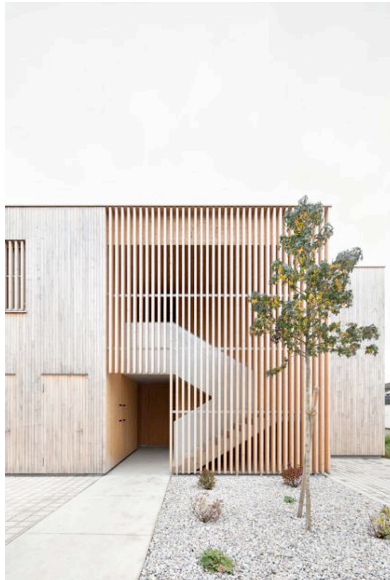
Beispiel Eingangstreppe mit aufgelöster Holzfassade
