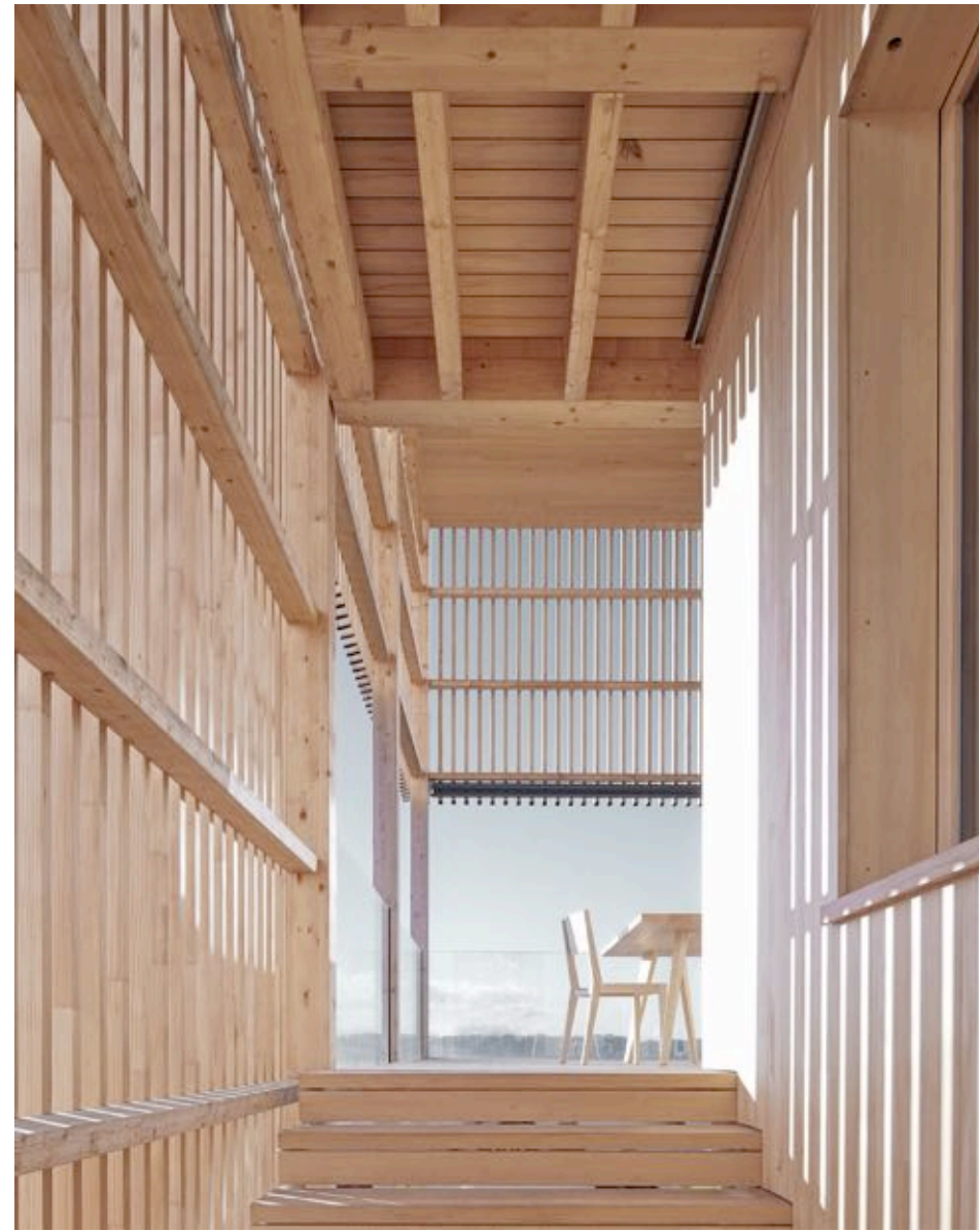
Beispiel Eingangstreppe mit aufgelöster Holzfassade
