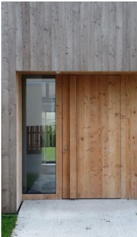
Beispiel Alterung Holzfassade bewitterte und unbewitterte Flächen
