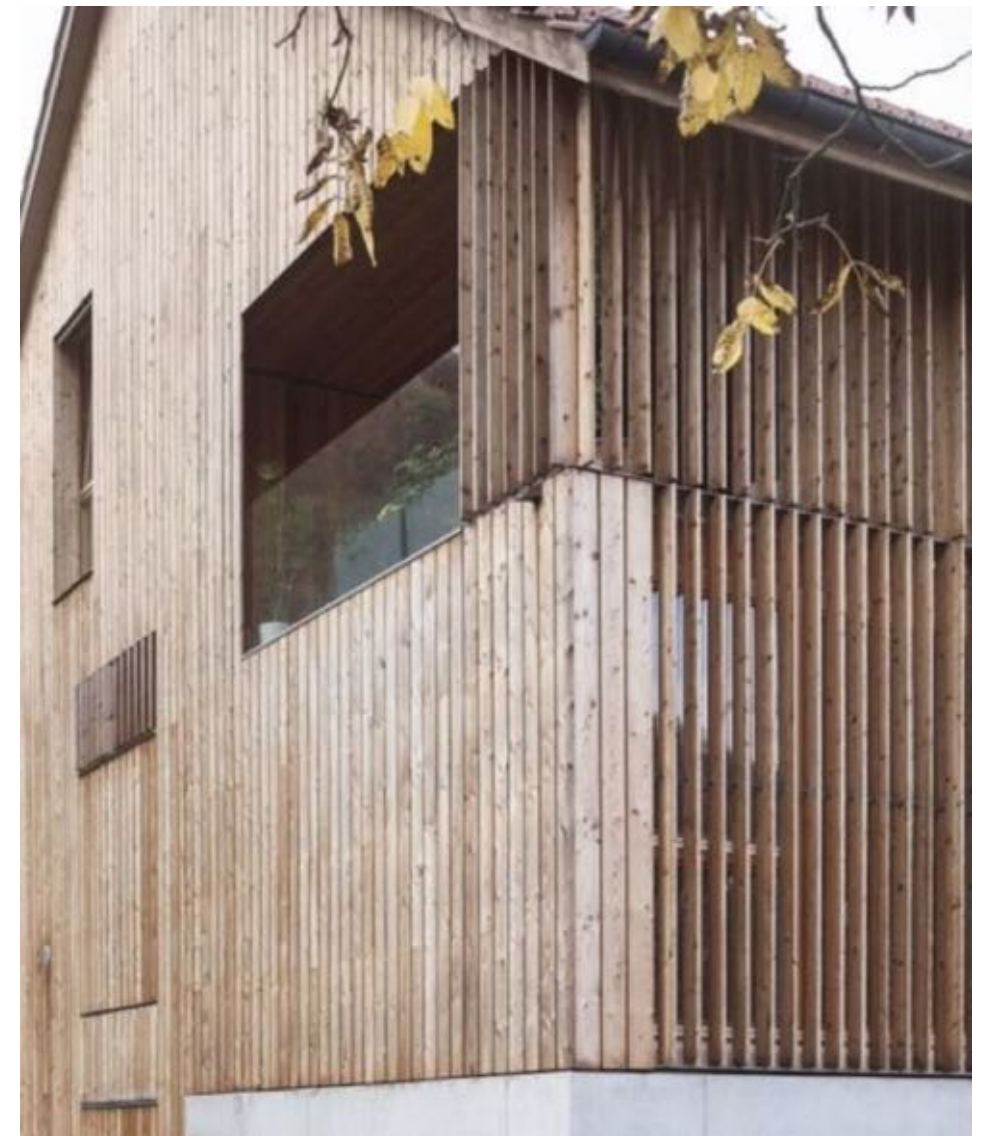
Beispiel Loggia Fassadenecke Süd
