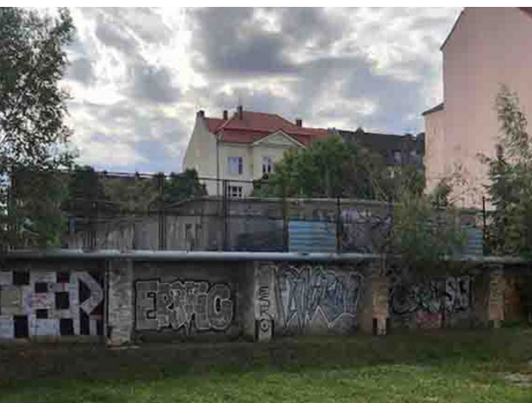
Abbildung 6: Rückansicht mit Stützmauer Quelle: BIM Berliner Immobilienmanagement GmbH
