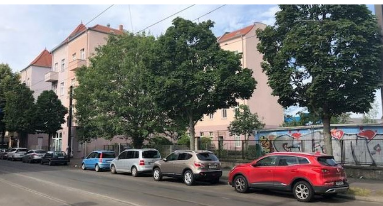
Abbildung 2: Straßenansicht Brückenstraße Quelle: BIM Berliner Immobilienmanagement GmbH
