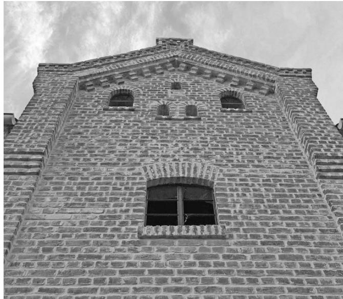
Giebel mit den denkmalgerecht wiederhergestellten Backsteinverzierungen
