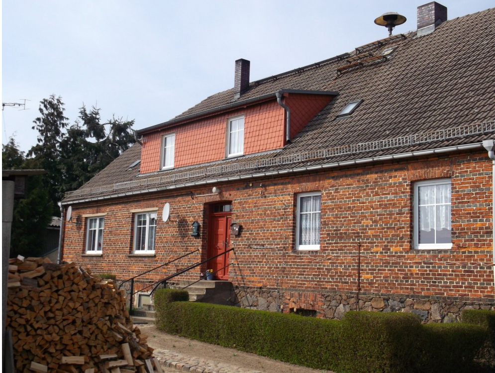
Abbildung 2: Gutsverwalterhaus Ansicht Hofseite
