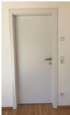
Innentüren Trägermaterial: Röhrenspan Oberfläche: matt, lackiert Farbe: weiß Zarge: Umfassungszarge
